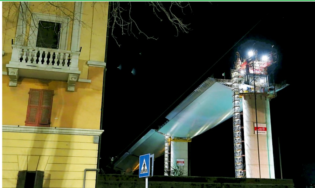
▲ Al lavoro Completato l'innalzamento della terza maxicampata del viadotto (foto Bussalino)
