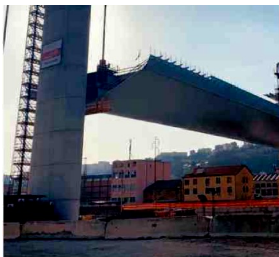
Operazioni di sollevamento dell'impalcato più lungo del ponte
