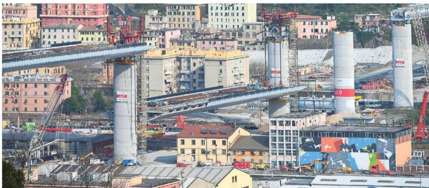
La lenta ascesa della terza maxi campata del nuovo ponte disegnato da Renzo Piano, nonostante i timori per il coronavirus e il vento, i lavori per adesso non si fermano
