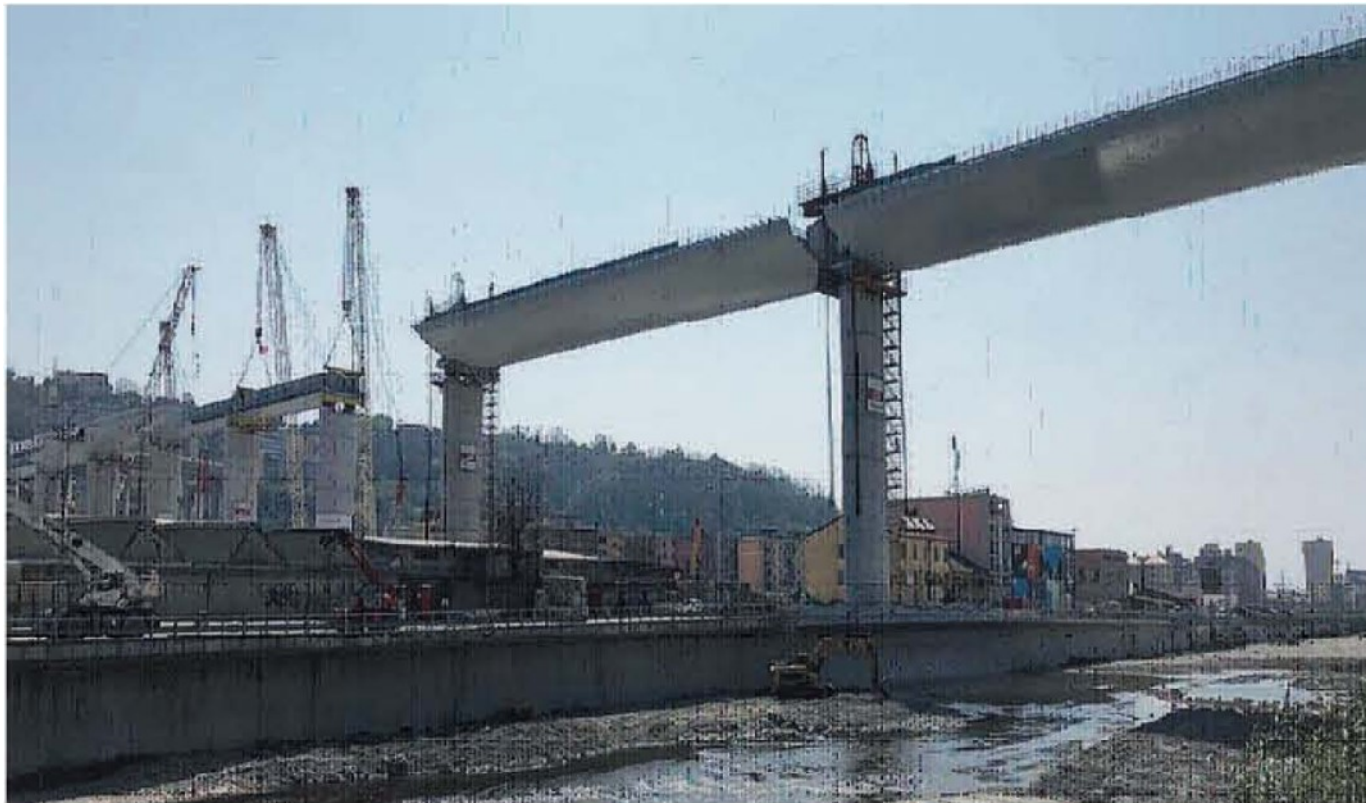
Dal crollo alla ricostruzione. Il Ponte di Genova chiamato a cancellare la ferita del crollo del Morandi, avvenuto il 14 agosto 2018
